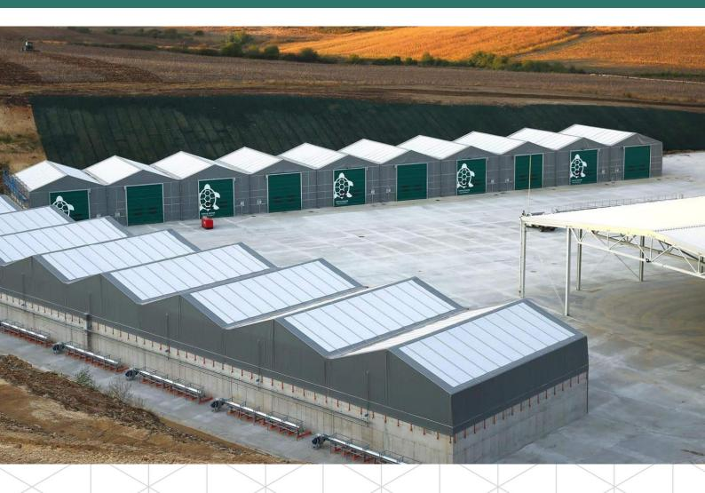
LE BIOCELLE TURTLE CON IL TETTO DI COPERTURA IN TESSUTO TRASPIRANTE Q-RING® SONO UN SISTEMA SEMPLICE, CONVENIENTE E MODULARE PER FAR MATURARE LE BIOMASSE IN SPAZI CONFINATI
