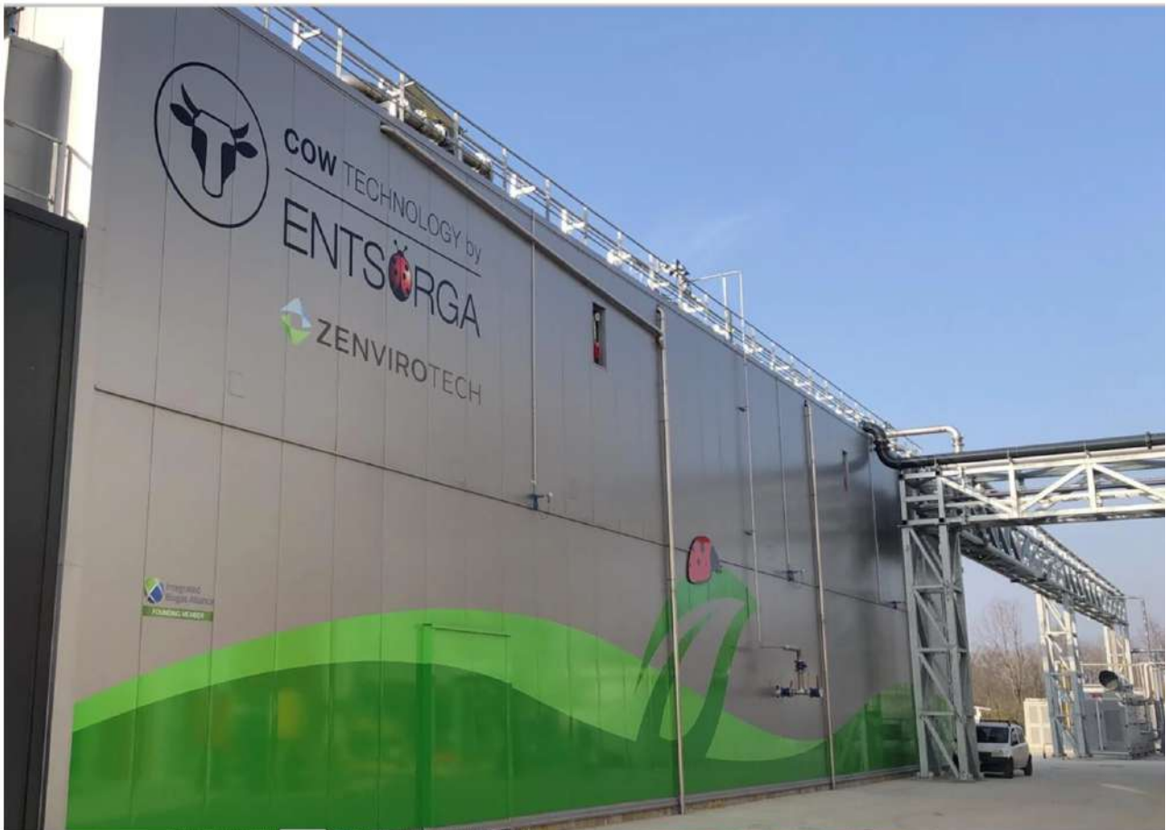
Digestore anaerobico "Cow" con sistema semi-dry, sviluppato da EntSORGA in collaborazione con Zenvirotech
